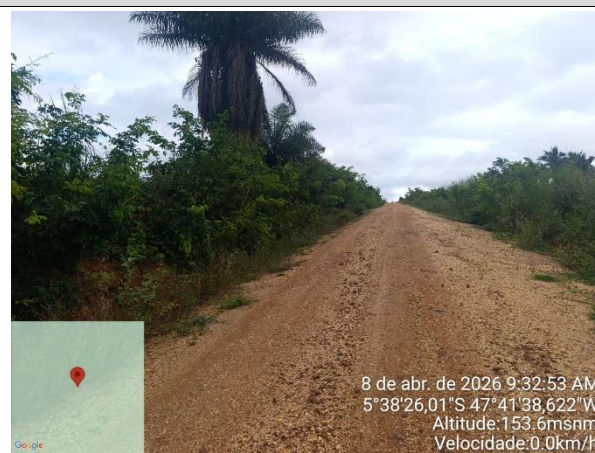
VISTA FIM Trecho 1
