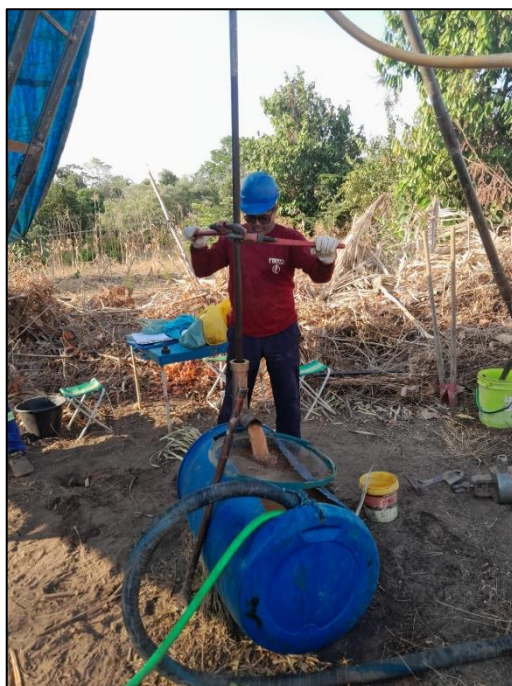
EXECUÇÃO DA SONDAGEM A PERCUSSÃO – SPT-03
