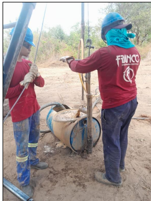
EXECUÇÃO DA SONDAGEM A PERCUSSÃO – SPT-02
