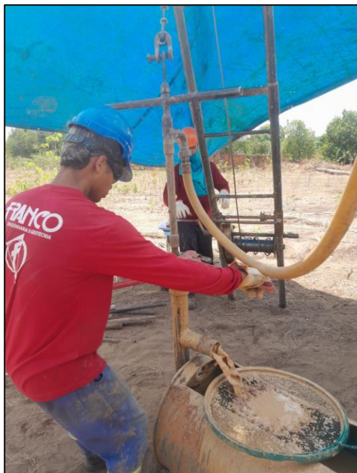
EXECUÇÃO DA SONDAGEM A PERCUSSÃO – SPT-01
